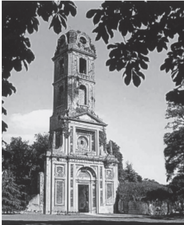
Parc Paradisio, tour abbatiale de l'ancienne abbaye cistercienne de Cambron-Casteau. La structure de cette tour datant du 18 e siècle menaçait de s'ébranler. Elle est désormais sécurisée et intégrée dans le parcours du parc ornithologique et animalier.
