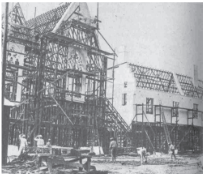
Le chantier de construction de la réplique de l'église Saint-Jacques sur Coudenberg et des maisons de l'ancienne rue du Coudenberg. Bulletin Officiel de l'Exposition N°13, 15 août 1934.
