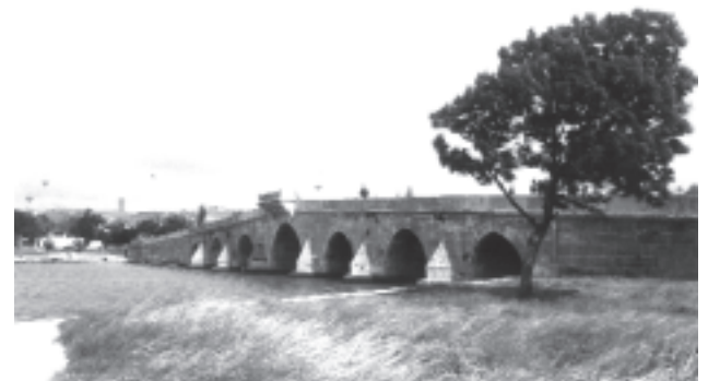
Pont de Biiyükcemecce sur la route d'Istanbul vers l'Europe.
