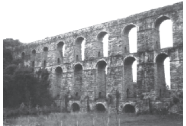
Aqueduc d'Egrî (1554-1560) construit par MIMAR SINAN pour l'alimentation d'Istanbul (hauteur 35m, longueur 342m).
